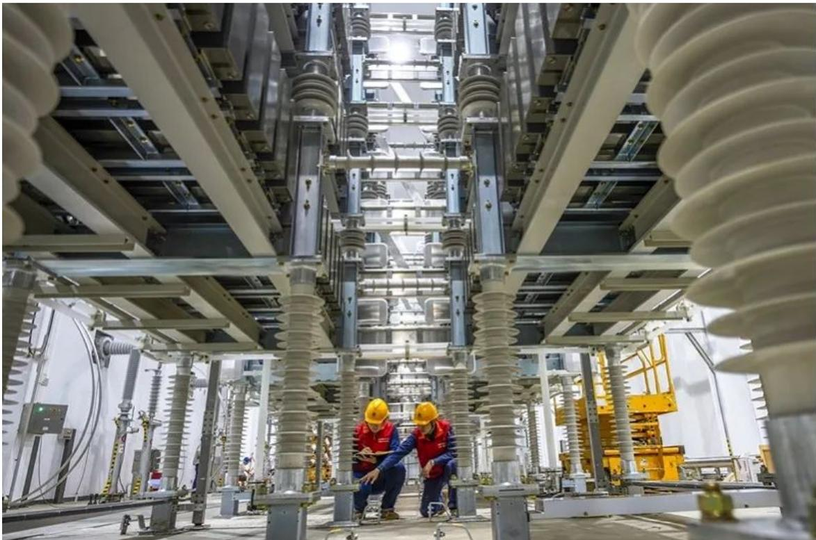
▲国网浙江杭州供电公司员工在杭州220千伏柔性低频输电工程中埠换频站开展支撑绝缘子基础安装可靠性检查
