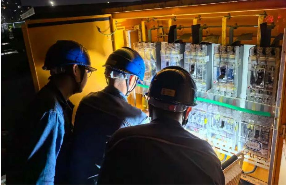
工作人员正在进行380V配电箱接线启动潜水泵抽水工作
